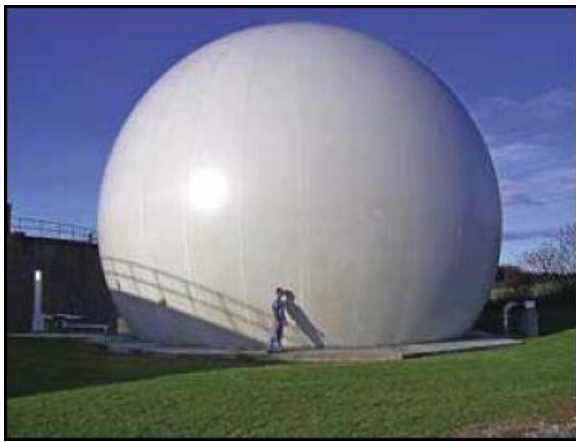
Dual-Membrane Gasholder
