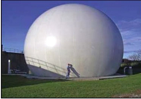
Dual-Membrane Gasholder
